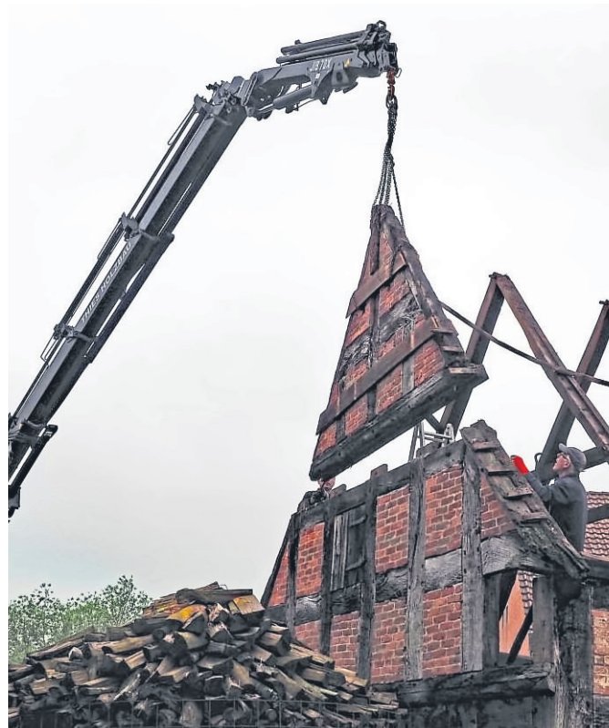
Bergung von kompletten Elementen: Dafür sind natürlich große Geräte notwendig.
