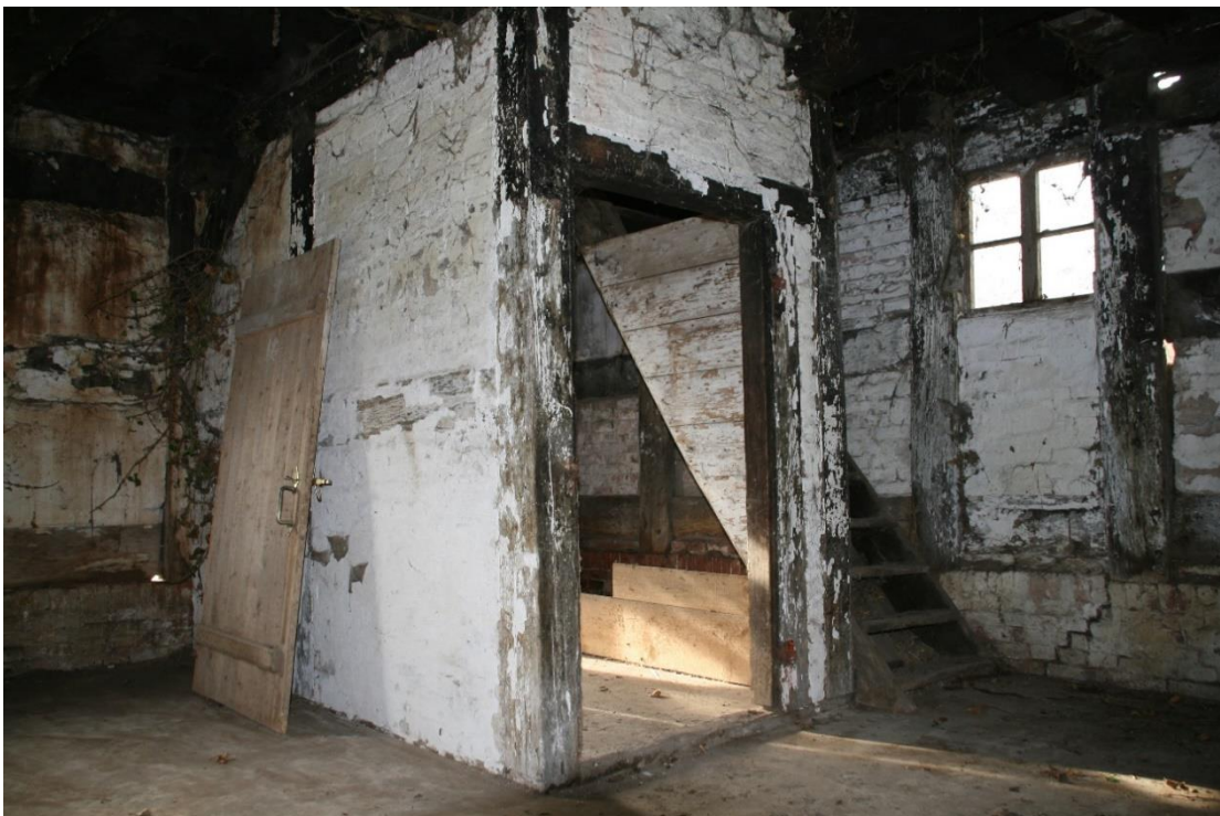
Kleine Kammer (6 qm) und Treppe zum Boden.
