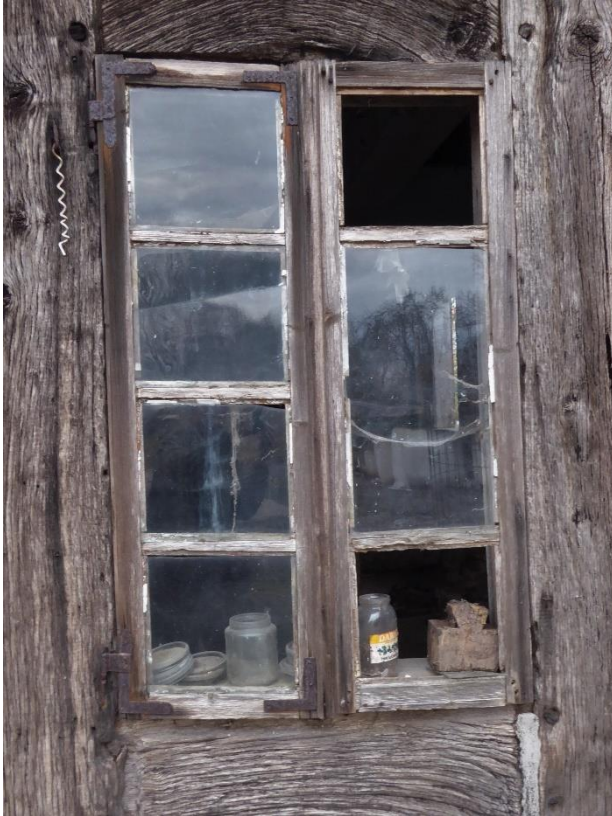
Fenster in der Südwand.
