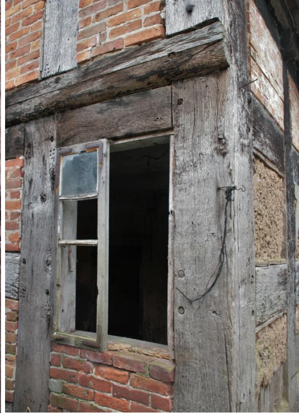
Fenster im östlichen Giebel.
