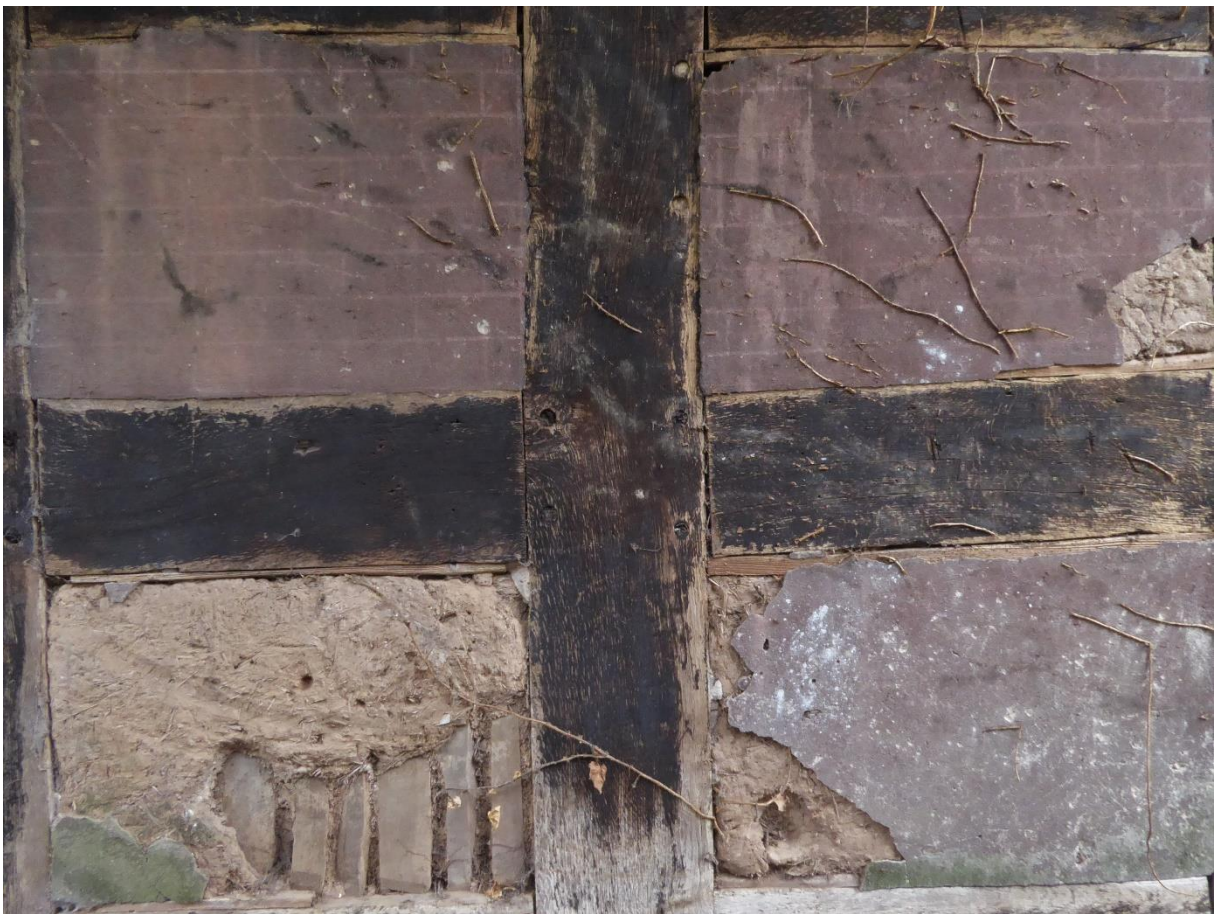
Nördliche Traufwand: Staken und Lehm, Zementputz und restliche Übermalung mit Fugenbild.
