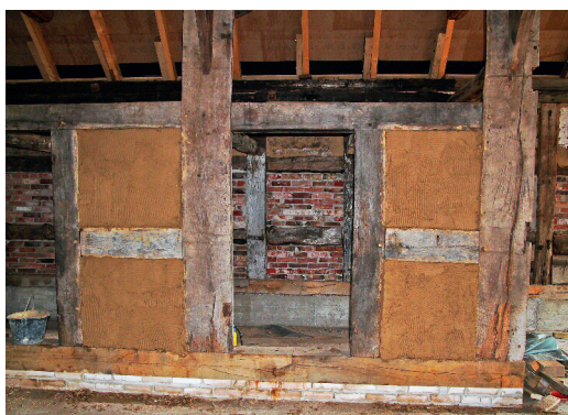
Lehmbauarbeiten an Kochs Hof. Der Lehm wurde in einer alten Teigrührmaschine vom Bäcker angerührt und über das Weidenzweiggeflecht gestrichen. Von dem Geflecht und der mühseligen Arbeit ist nun nichts mehr zu sehen. (Fotos Armin Weyde)
