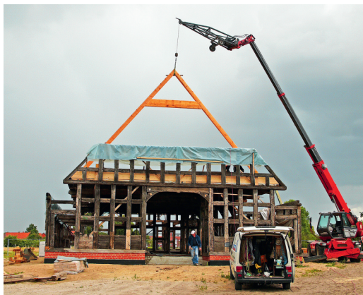
Mit schwerem Gerät werden die Zimmereiarbeiten ausgeführt.
