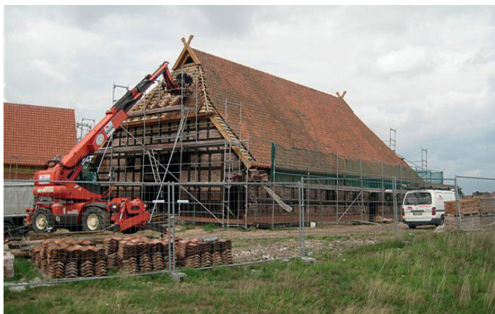
Die Firma Hestermann Bedachungen bei der Eindeckung des Daches mit historischen „Handform-Hohlziegel“ nach alter handwerklicher Art.
