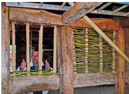
Lehmbauarbeiten an Kochs Hof. Der Lehm wurde in einer alten Teigrührmaschine vom Bäcker angerührt und über das Weidenzweiggeflecht gestrichen. Von dem Geflecht und der mühseligen Arbeit ist nun nichts mehr zu sehen. (Fotos Armin Weyde)
