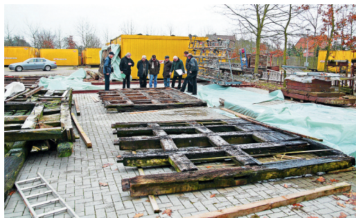
Begutachtung des Fachwerks auf dem Betriebshof der Firma Wiebe.
