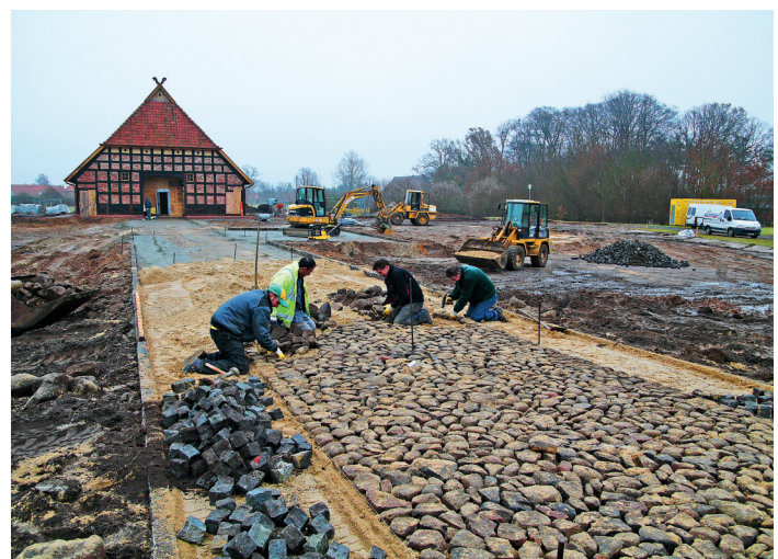
Die Pflasterarbeiten haben begonnen ... (Foto Armin Weyde)
