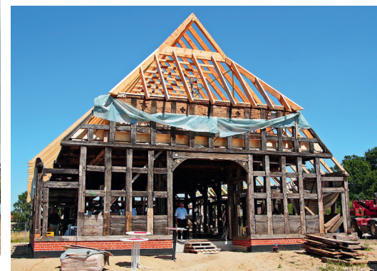
Das Gerüst steht. (Fotos Armin Weyde)
