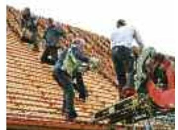
Die Firma Fischer war für die Bedachung zuständig. (Fotos: Armin Weyde)
