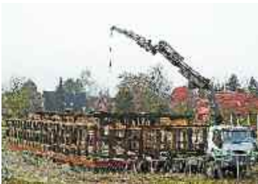
Die Firma Thies Holzbau ist mit schwerem Gerät dabei, das Fachwerk millimetergenau aufzustellen. (Fotos: Armin Weyde)
