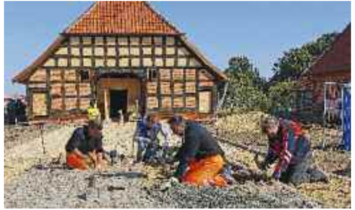
Kompetenz und Einfühlungsvermögen sind gefragt bei den Pflasterarbeiten mit Natursteinen durch die Firma Messenbrink. (Fotos: Armin Weyde)
